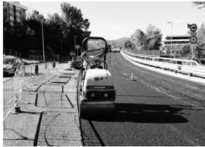
— I lavori del viadotto Vaccaro giunti al termine, con il rifacimento dell'asfalto (foto Mattiacci)
