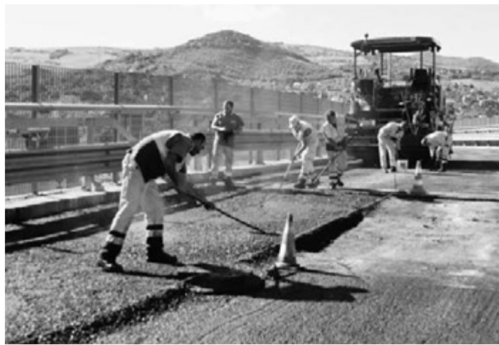
— I lavori del viadotto Vaccaro giunti al termine, con il rifacimento dell'asfalto (foto Mattiacci)
